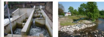
Exemple de dispositif de franchissement d'un obstacle transversal : à gauche passage à poisson / à droite obstacle de franchissement (photo de gauche : CEMEA / photo de droite : Agence de l'eau Rhin-Meuse)
