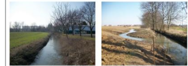
Exemple d'implémentation de reméandrage par terrassement (photos : Agence de l'eau Rhin-Meuse)
