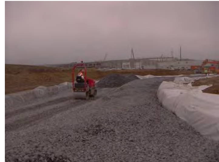
Application mécanisée classique
